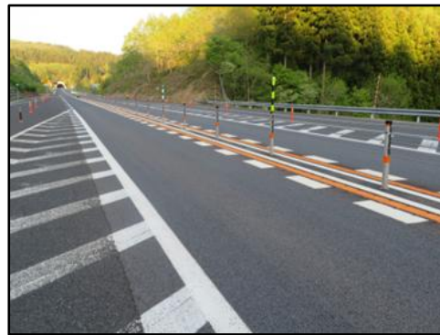
舗装補修後写真（イメージ）
