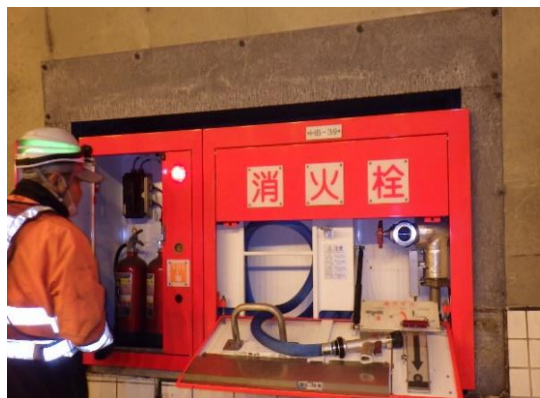
トンネル非常用設備点検
