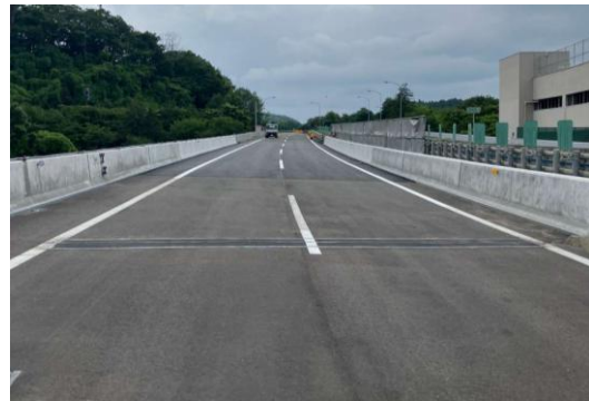
舗装補修後イメージ
