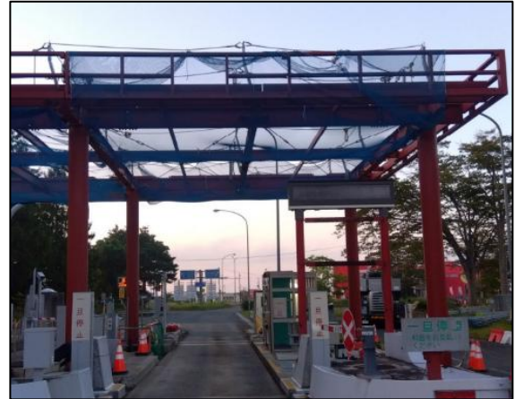
料金所上屋鉄骨建て方後イメージ
