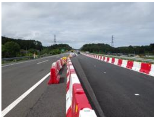
車線運用切替工事 イメージ写真
