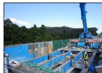
【古い床版撤去状況】
