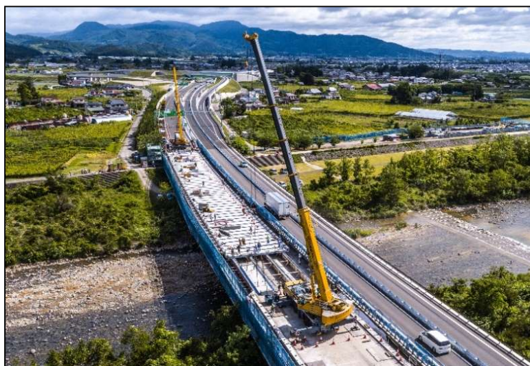
【対面通行規制状況】
