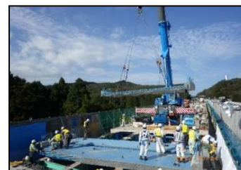
【新しい床版設置状況】
