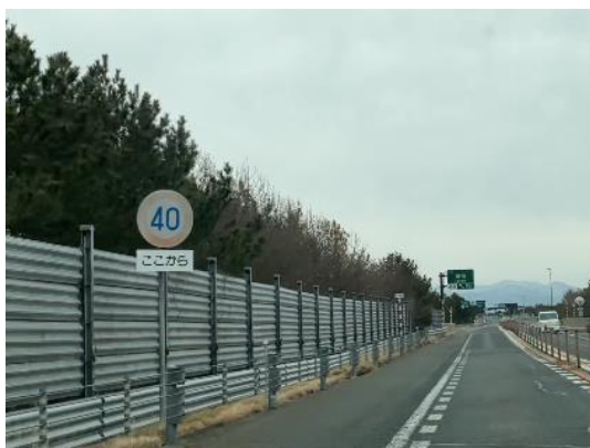
樹木繁茂写真
