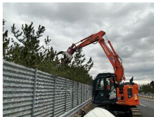
高伐作業写真
