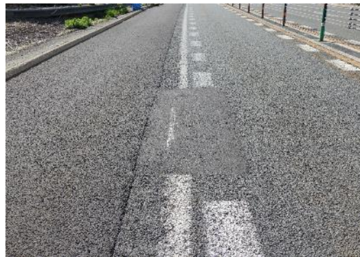
舗装補修後イメージ
