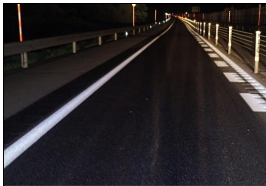
舗装補修後イメージ
