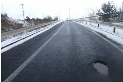
舗装補修箇所
