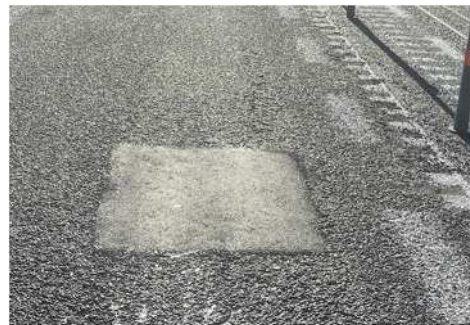
舗装補修後イメージ
