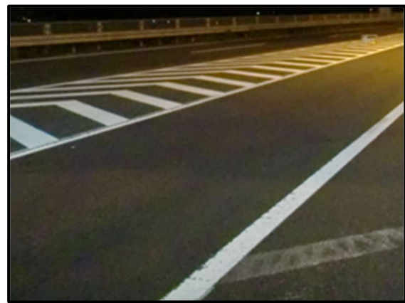
舗装補修後イメージ
