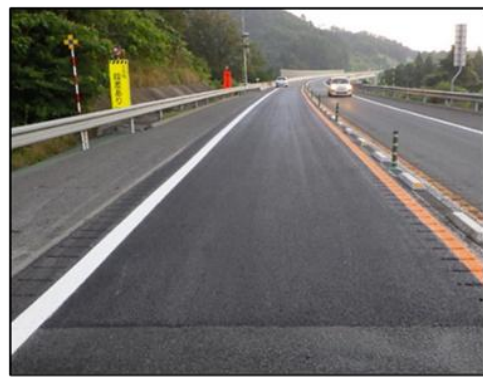
道路保全工事 施工後写真(イメージ)
