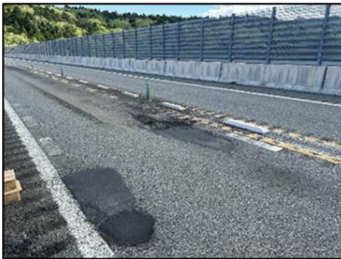
道路保全工事 施工前写真
