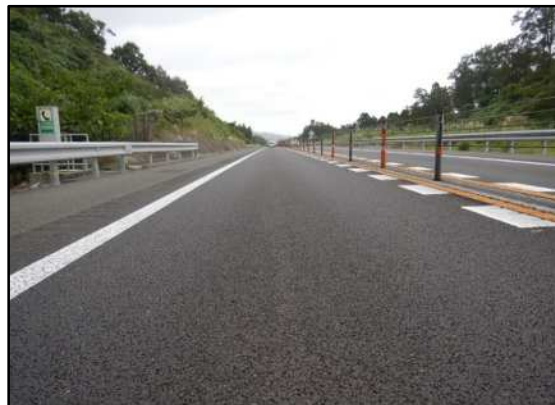
舗装補修後イメージ
