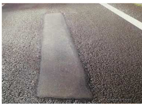
舗装補修後イメージ
