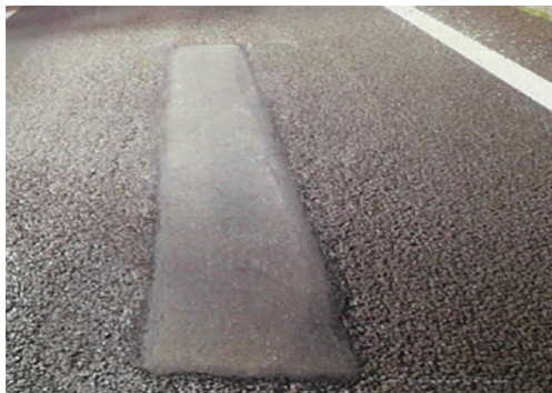
舗装補修後イメージ
