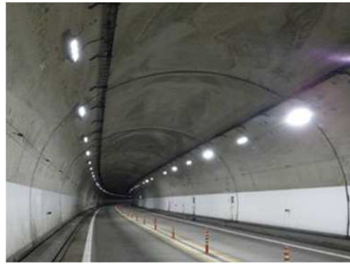
照明更新作業後イメージ
