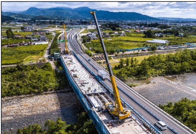
【対面通行規制状況】
