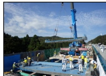
【新しい床版設置状況】
