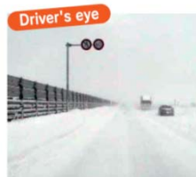
▲ 路側の防雪柵が吹雪も防止
